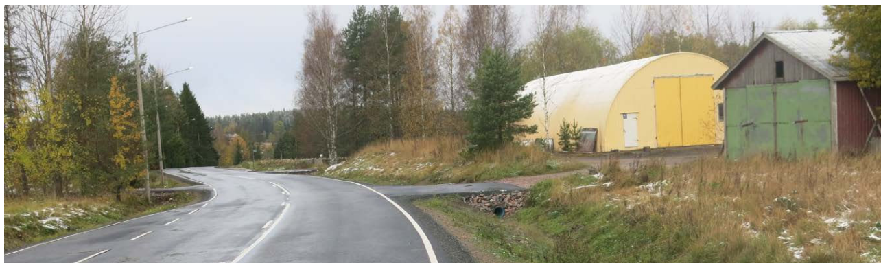
Kolme rakennuspaikkaa tukeutuu olemassa olevaan maantien turvalliseen liittymään
